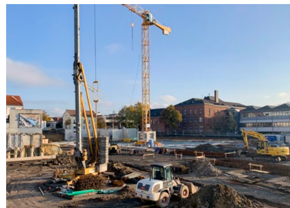
Erdarbeiten, Homberg / Efze, 2019
