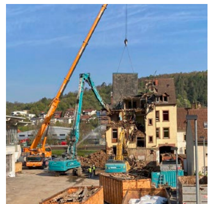
Rückbau Geschäftshaus, Mosbach, 2021
