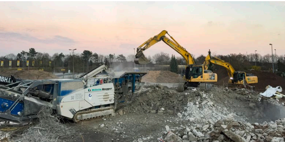
Abbruch und Erdarbeiten in Hanau, 2015
