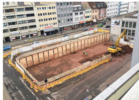
Verbau- und Erdarbeiten, Bad Kreuznach, 2017
